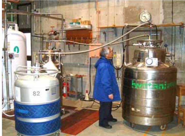
図は液体ヘリウム 500L を購入し、二つの小容器へ同時に液を移送しているところ。作業はセンター職員が行う。液体ヘリウムの移送管は、当センターと業者で共同作製した逆支弁付脱着型のものを用いて作業の効率化を図っている。汲出し時にピットは不要であるし、逆支弁付きなので、充填後容器の内圧が上がっていても移送管を取り外すことができ、次々汲出し作業ができる。
