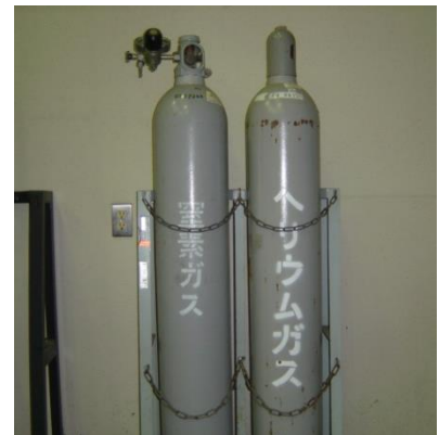
Fig. 21. 高圧ガスの固定方法
